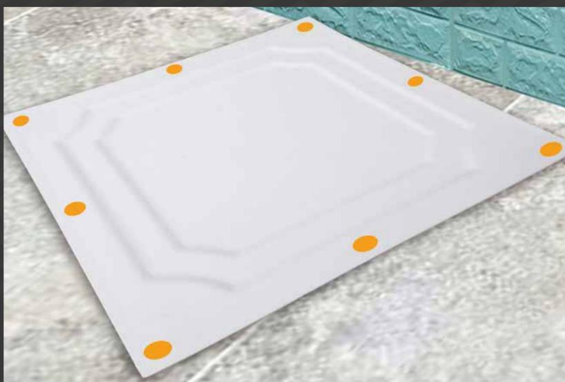
**Paso 3:** Adhesivado de las placas. Colocar el adhesivo en forma de círculos de 2x2 cm en los puntos indicados en la foto.
