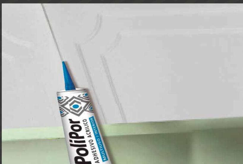
**Paso 6:** Al finalizar la instalación, en caso de colocarse en baños, las placas pueden ser selladas entre sí mediante la aplicación de sellador acrílico **Polipor** y así lograr una terminación más delicada y homogénea.
