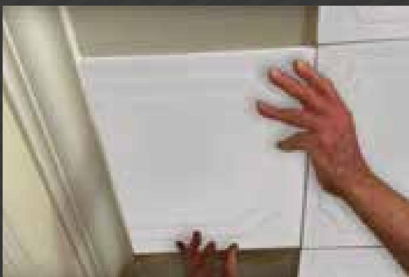
**Paso 5:** Al llegar a los extremos, cortar las placas a la medida requerida y repetir la operación hasta dar terminación a todo el paño. En el caso de requerirlo, coloque las molduras elegidas.
