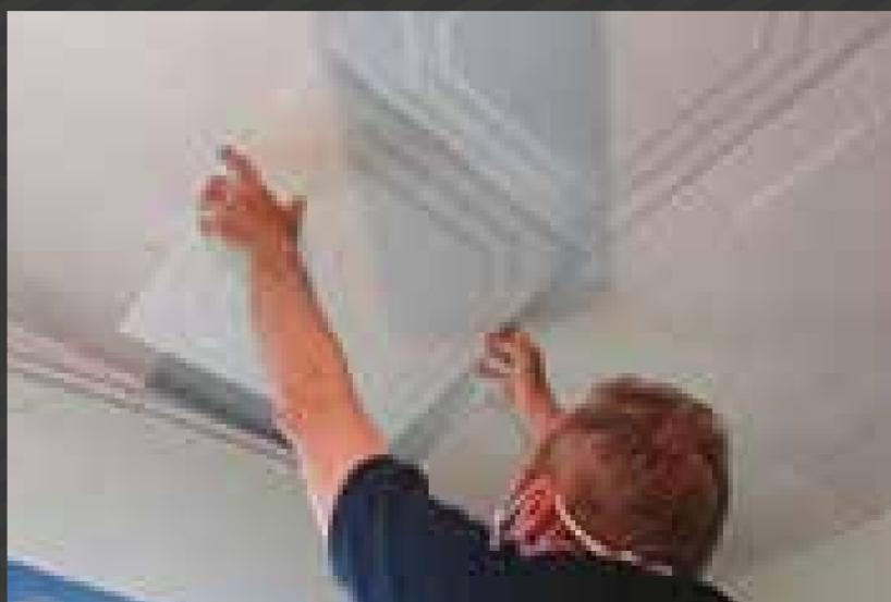
**Paso 4:** Comenzar la instalación a partir del centro del ambiente, extendiéndose hacia las paredes. Una vez en la posición deseada, presionar la placa.
